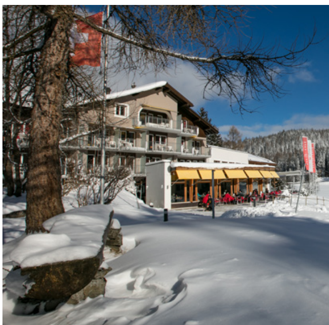
Der Restaurantanbau (vorne) hielt dem Schmelzwasser nicht immer stand. Im Herbst wird er nun umfassend saniert.
